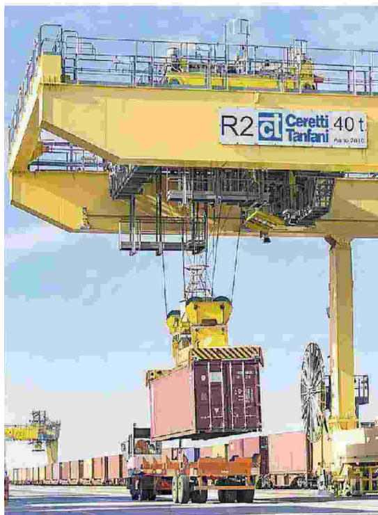
Movimentazione di un container nel porto di Trieste
